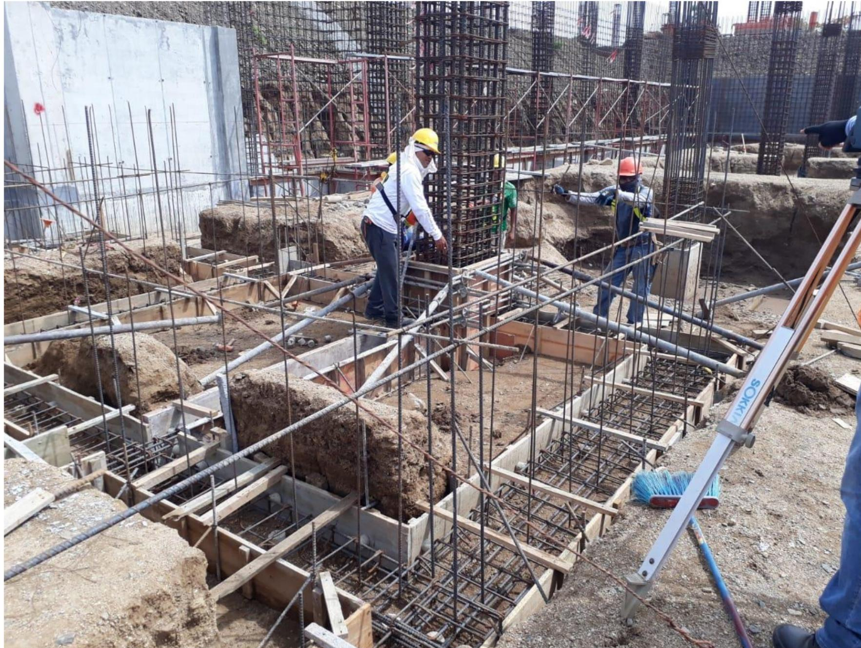
Armado de columnas y encofrado en solera de fundación.
