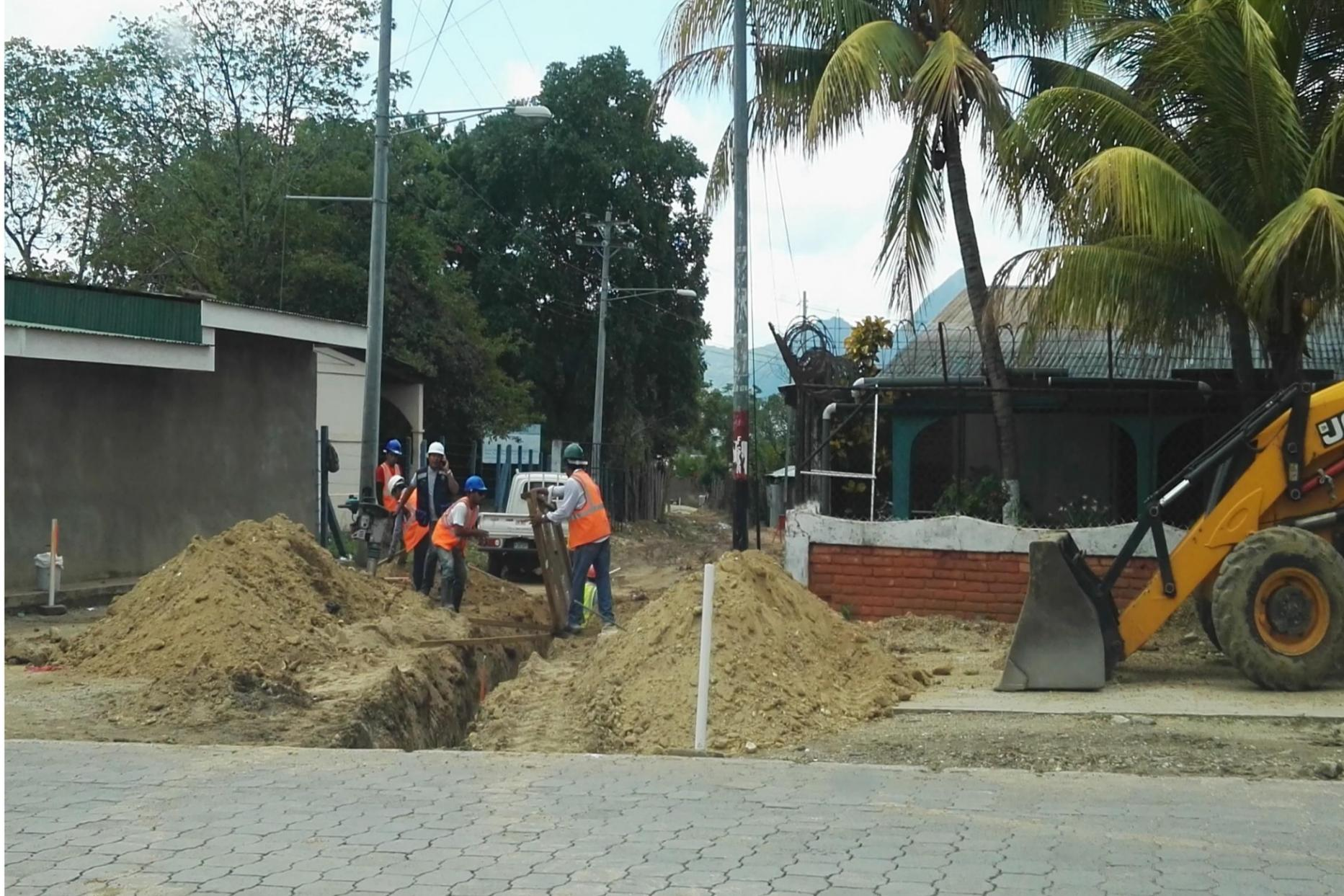
Instalación de Tubería de 6" ultimo Tramo
